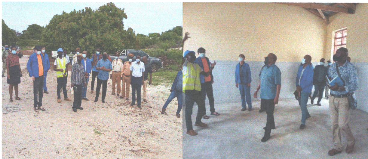
Figuras 1 e 2. Ilustram a visita de monitoria a e avaliação das obras de construção da EP1 de Quiricuidje
